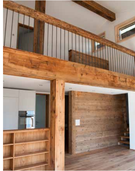
Die einstigen Ställe heute. Architekt Nüesch hat einen Grossteil der alten Holzstämmen wieder an der Originalposition verbaut. Auch im Innern wurde altes Stallholz wiederverwendet.
