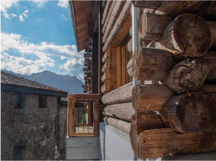
Die einstigen Ställe heute. Architekt Nüesch hat einen Grossteil der alten Holzstämmen wieder an der Originalposition verbaut. Auch im Innern wurde altes Stallholz wiederverwendet.
